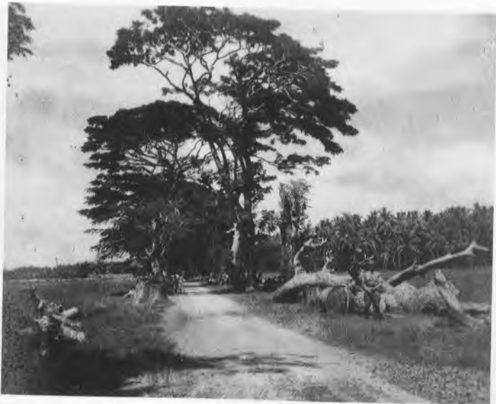
セラン街道 (爆破された倒木タマリンダは工兵隊により撤去後)
