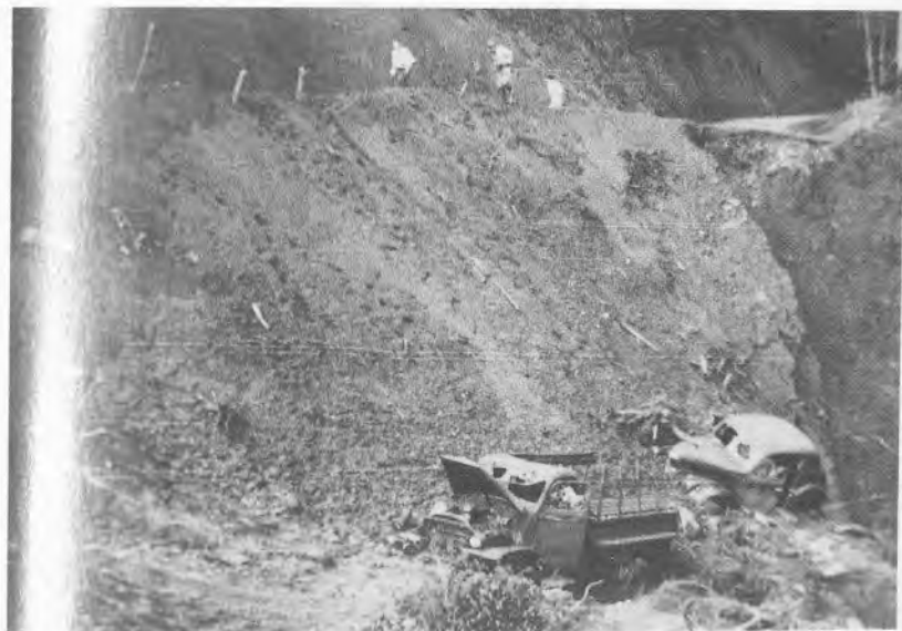
爆破されたボンチャック峠への道（左端）
